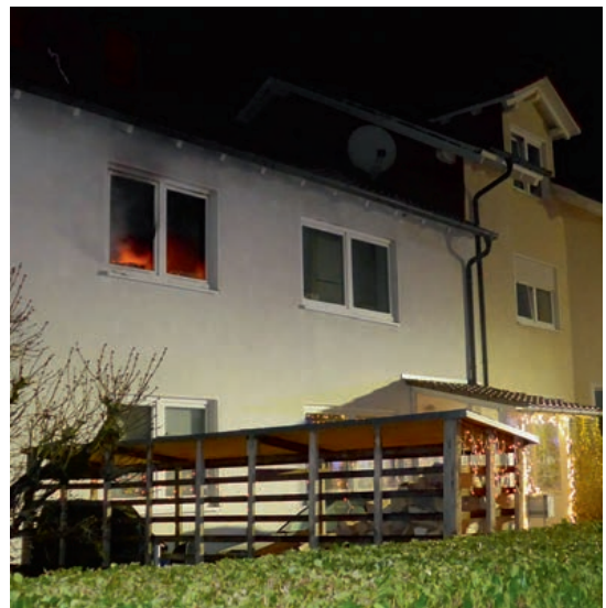
Kurz vor Neujahr: In Kassel brannte es in einem Einfamilienhaus.
