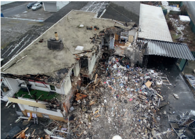
Sonntagvormittag, nach Abriss des Gebäudeteiles.
