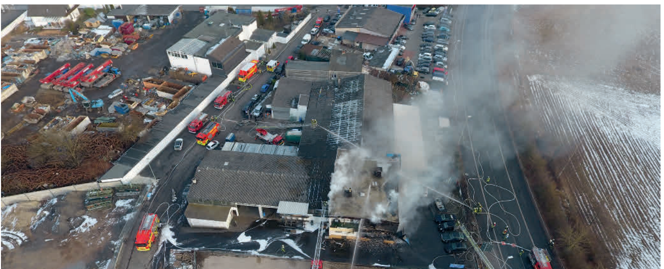
Luftaufnahme mittels Drohne, eine Stunde nach Brandausbruch.
