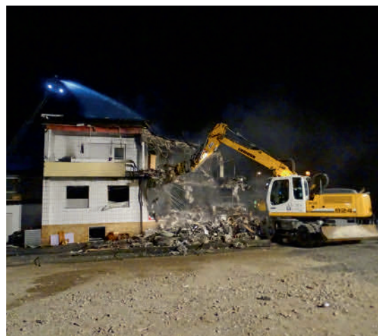
Abrissarbeiten des vorderen einsturgefährdeten Bereiches.
