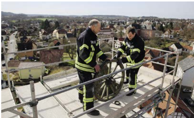
Uwe Rein und Kevin Planz bei der Demontage des alten Wagenrades.
