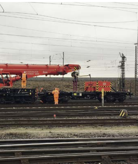
160 Tonnen Notfallkran der DB Netz Notfalltechnik kurz nach dem Eintreffen im Bahnhof Bischofsheim.
