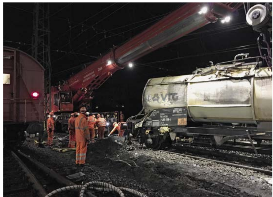
Kesselwagen nach dem Aufrichten und während der Vorbereitung der Hilfsdrehgestelle.
