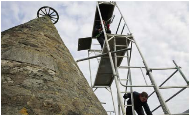
Gerüstbauer bei der Errichtung des etwa sechs Meter hohen Gerüsts auf dem Turm.
