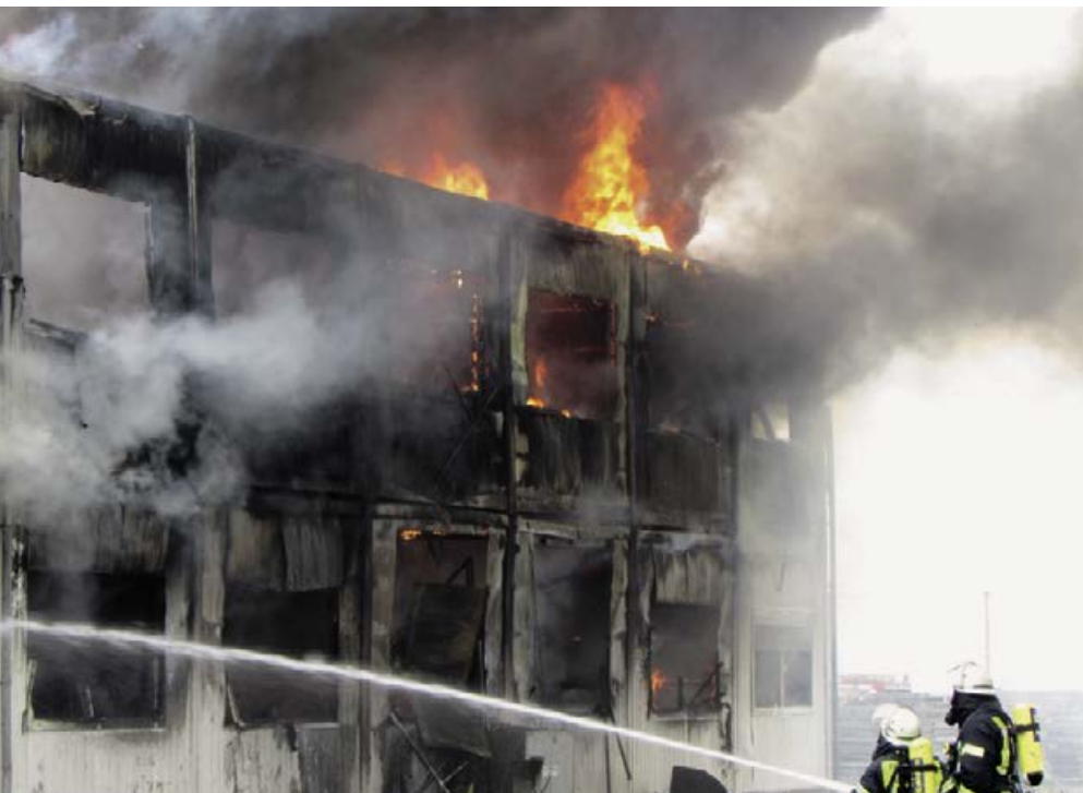
Die Feuerwehr Calden bei der Erstbrandbekämpfung mit B-Rohren auf der Rückseite der Wohneinheit.
