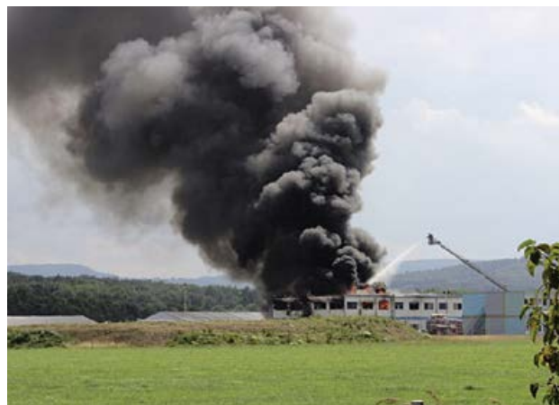
Große Rauchschwaden treiben nach dem Großbrand über die Erstaufnahmeeinrichtung in Richtung der Wohngemeinde Calden.
