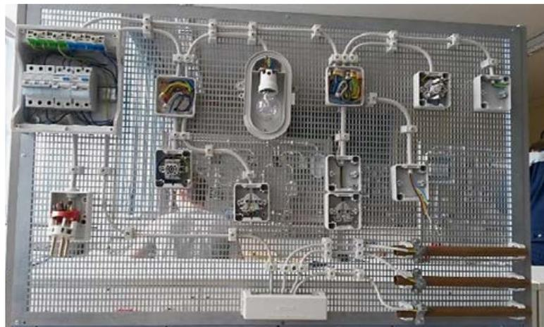
Arbeitsprobe praktische Prüfung Teil 1: Prüfungswerkstück Elektro nach der Zwischenprüfung nach den 18 Monaten handwerklicher Ausbildung
