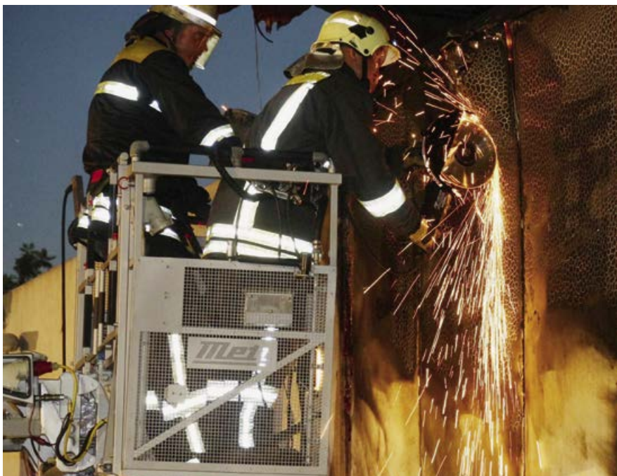
Einsatzkräfte beim Öffnen der Blechwand mittels Trennjäger von der Drehleiter aus.
